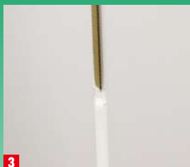
1 食品工場を想定した模擬研修施設「Practical Training Room」(5階) / 2 壁の一部がくり抜かれ、エキスパンションジョイントの中身が確認できる / 3 コーキングが一部抜け落ちた壁面 / 4 配管部分が目視確認できる天井カセット型エアコン / 5 忠実に再現された天井裏の模擬施設
