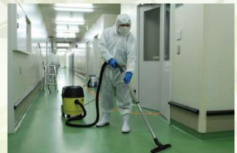
●乾湿両用掃除機による薬液回収
